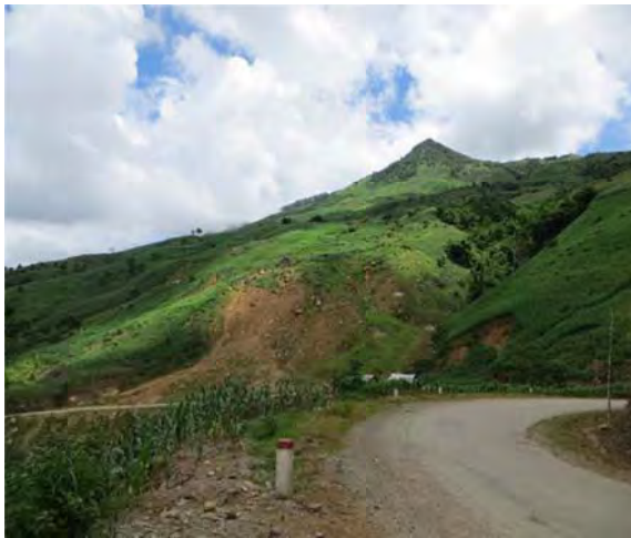
Hình 13: Trượt lở nghiêm trọng tại vết lộ SL.106 143 MB khu vực xã Hua Nhàn; QL.37 Bắc Yên - Sơn La.
