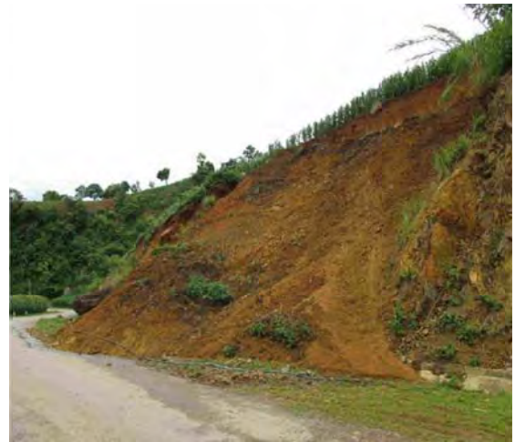
Hình 14: Trượt lở nghiêm trọng tại vết lộ SL.106 144 MB khu vực xã Hua Nhàn; QL.37 Bắc Yên - Sơn La.
