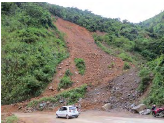
Hình 26: Trượt tự nhiên tại vết lộ SL.100 103 MB khu vực xã Tạ Bú; tỉnh lộ 106.
