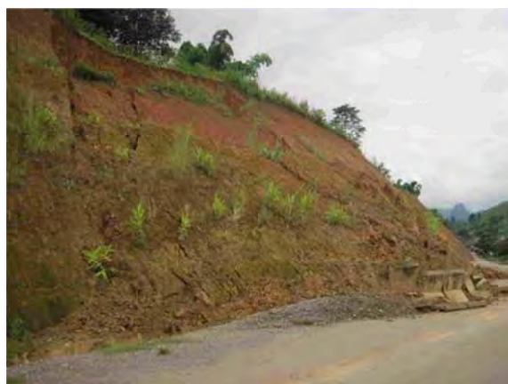
Hình 33: Trượt lở trong đới PH hoàn toàn tại vết lộ SL.113 203 MB khu vực xã Chiềng Bằng, huyện Quỳnh Nhai.
