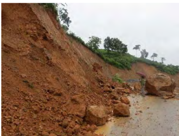
Hình 32: Trượt lở trong đới PH hoàn toàn tại vết lộ SL.103 331 MB khu vực xã Pa Khinh; tỉnh lộ 107.
