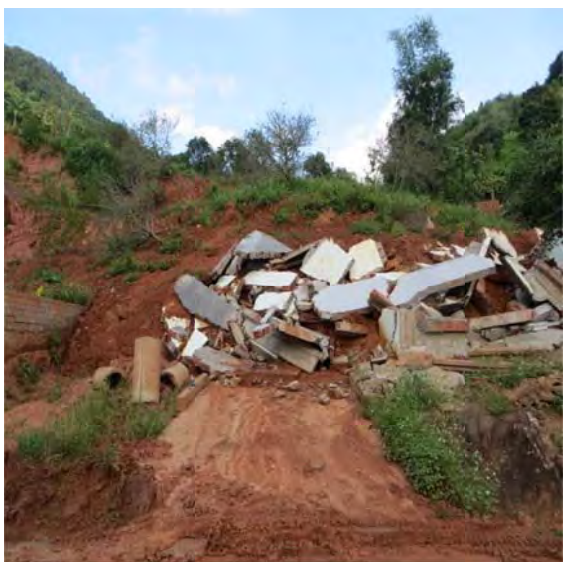
Hình 22: Trượt lở gây sập hoàn toàn nhà dân tại vết lộ SL.102 576 MB khu vực xã Mường San, QL.43 Mộc Châu - cửa khẩu Lóng Sập.
