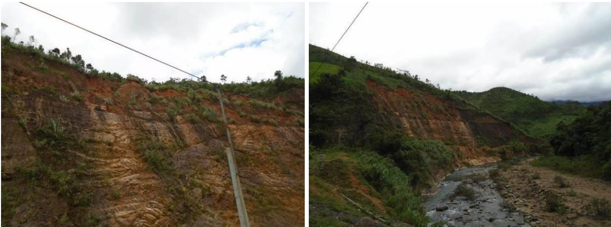
Hình 28: Khu vực khảo sát khối trượt QT.006161.KS trên đường Hồ Chí Minh thuộc địa bàn xã Hương Lập, huyện Hương Hóa, tỉnh Quảng Trị.
