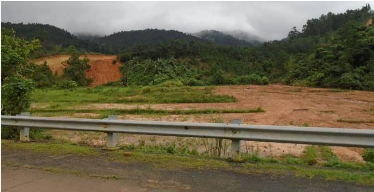
Hình 31: Dấu vết lũ quét còn ghi nhận được tại điểm khảo sát QT.006140.KS thuộc thôn Chênh Vênh, xã Hướng Phùng, huyện Hướng Hóa, tỉnh Quảng Trị.
