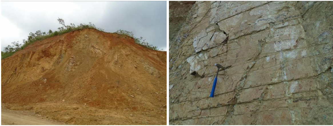
Hình 30: Khu vực khảo sát khối trượt QT.006110.KS thuộc địa bàn xã Hương Linh, huyện Hương Hóa, tỉnh Quảng Trị.
